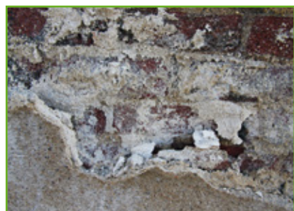
Typické poškodenie výkvetmi soli.
