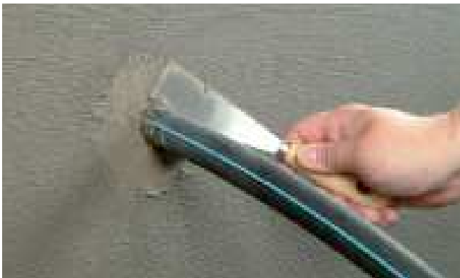
Na ochranu výrobku KÖSTER KB-Flex 200 je na jeho povrch aplikovaný výrobok KÖSTER KB-Fix 5 alebo KÖSTER Repair Mortar.
