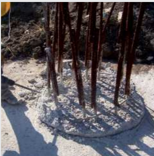
Odstránenie vyčnievajúceho betónu a čistenie povrchu
