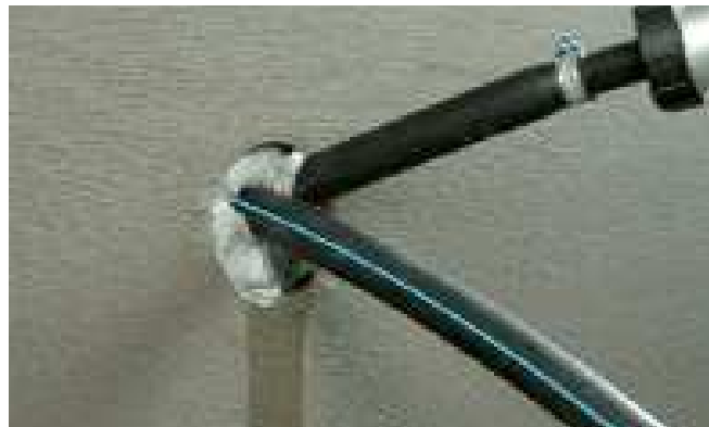
KÖSTER KB-Flex 200 sa vtlača do priestoru ručnou pištoľou KÖSTER.
