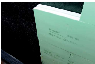
S KÖSTER Deuxan 2K je možné izolačné dosky jednoducho nalepiť na hydroizoláciu. Dôležité je celoplošné lepenie.
