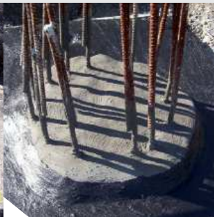
Napojenie povrchovej hydroizolácie (KÖSTER Deuxan 2K) na hydroizoláciu hlavy pilóty
