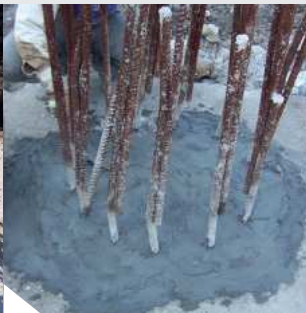
Vyrovnanie povrchu hydroizolačnou maltou KÖSTER WP Mortar alebo KÖSTER Repair Mortar.
