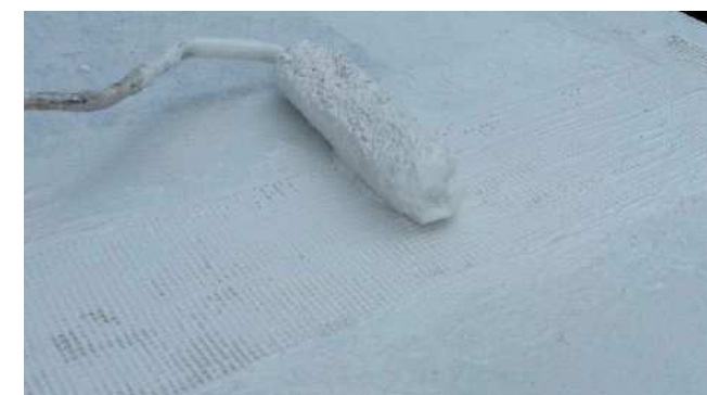
Prvá vrstva KÖSTER 21 a vložená sieťka KÖSTER Glass Fiber Mesh
