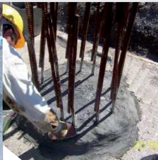
Tesnenie hlavy pilóty pomocou KÖSTER NB 1 Grey
