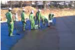
Hydroizolácia s KÖSTER Deuxan 2K
