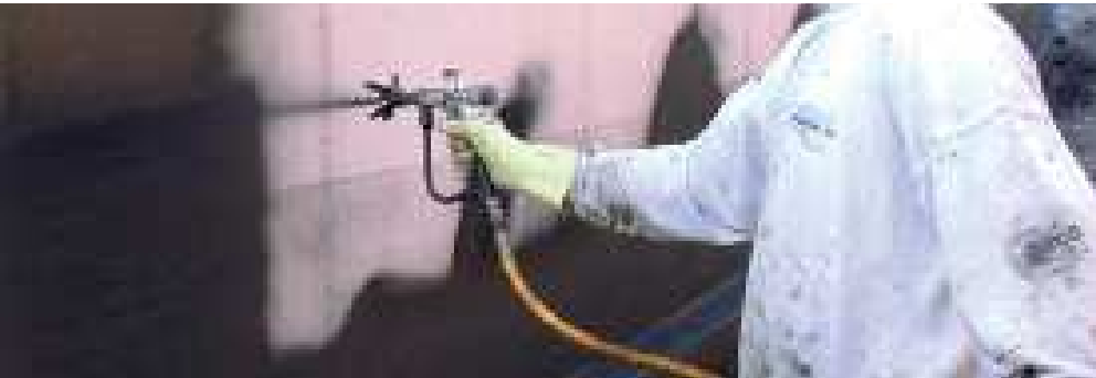
Ilustračný obrázok: Vzor striekania závisí od rýchlosti dopravy materiálu striekacieho zariadenia, vzdialenosti stavebného povrchu, veľkosti trysky a množstva prívádzaného vzduchu, atď.
