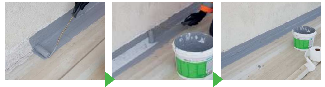
Napojenie na TPO strešné fólie
