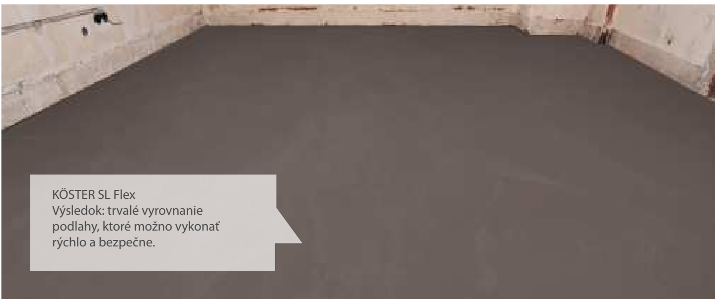
4 Nanesenie nivelačnej hmoty v požadovanej hrúbke vrstvy. (miešať najmenej 3 minúty).
