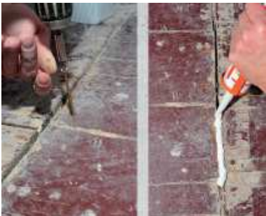
1 Príprava podkladu: Spevnenie voľných častí podkladu, očistenie podkladu. Venujte pozornosť dôkladnej príprave podkladu.
