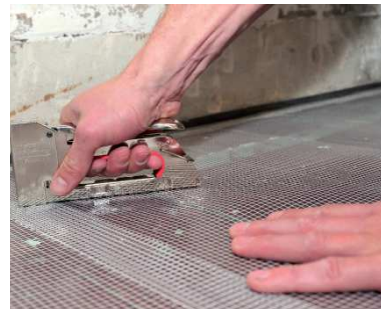
3 Aplikácia sklotextilnej sieťky KÖSTER Glass Fiber Mash na drevený podklad.
